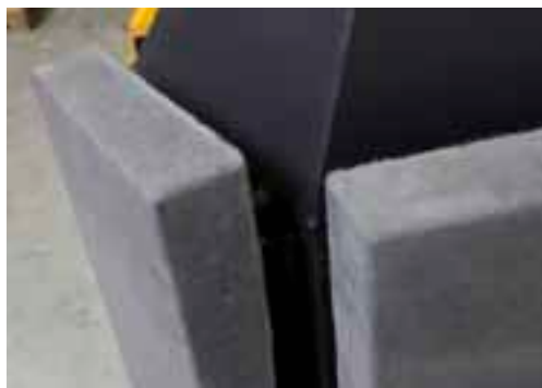
Elementy akumulacyjne nakładane są tylko na urządzenie -wkład
