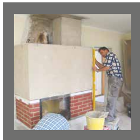
Otynkowana górna część konstrukcji zostanie dokładnie sprawdzona i precyzyjnie wyrównana.
