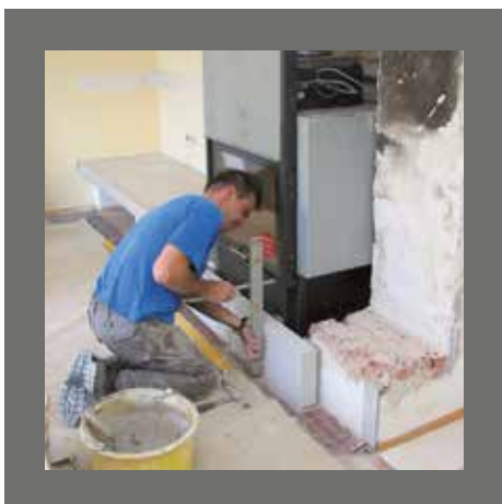
Teraz monter „posadzi” wkład na swoim miejscu.
