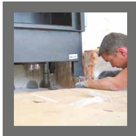
Pozycja ostateczna osiągnięta, przyłącza znajdują się nad otworami w posadzce; można wypoziomować urządzenie.
