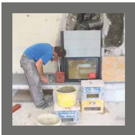
Przyłącze rury spalinowej wykonane, wkład kominkowy zostanie obudowany cegłami.
