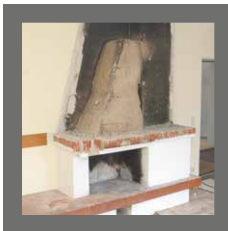
Demontaż kominka z otwartym paleniskiem i demontaż ciągu gazów spalinowych.
