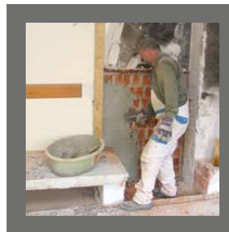
Tynkowanie surowej ściany ceglanej po zakończeniu montażu.
